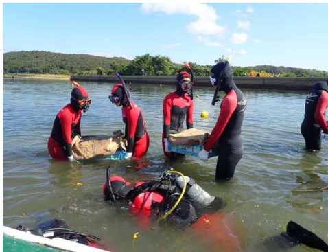
ダイバーによる海底への麻袋設置
